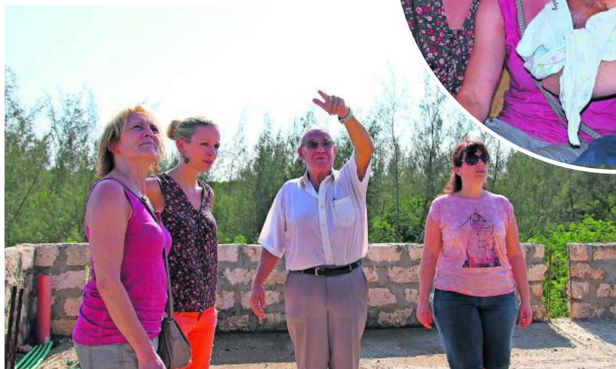
Peter Gessler erklärt Rita, Katrin und Julia Schütte (von links) die Arbeiten am Neubau.
