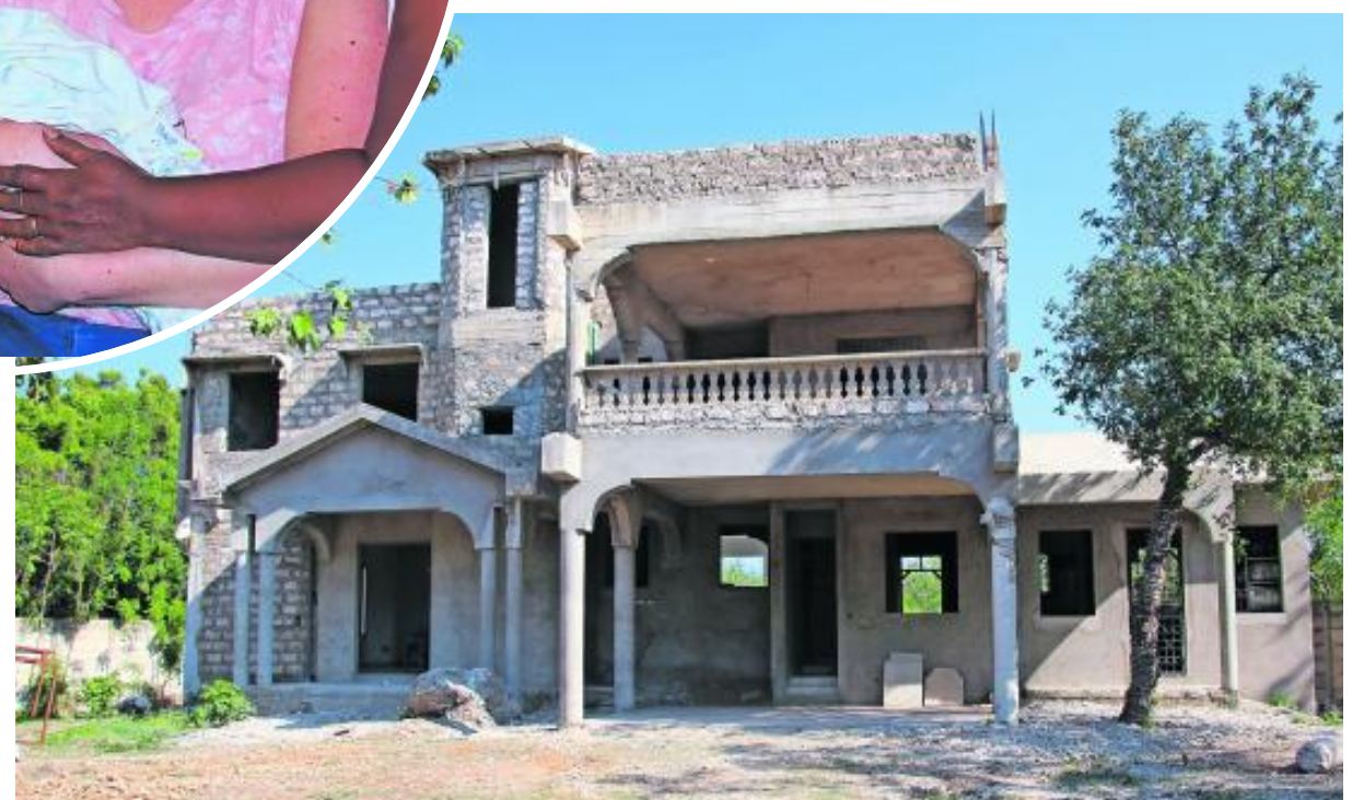
Der Rohbau des neuen Gebäudes ist bereits abgeschlossen.
