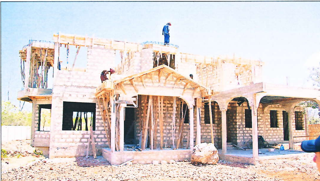
Im Frühjahr waren die Häuser im Rohbau – jetzt sind sie kurz vor der Fertigstellung.
